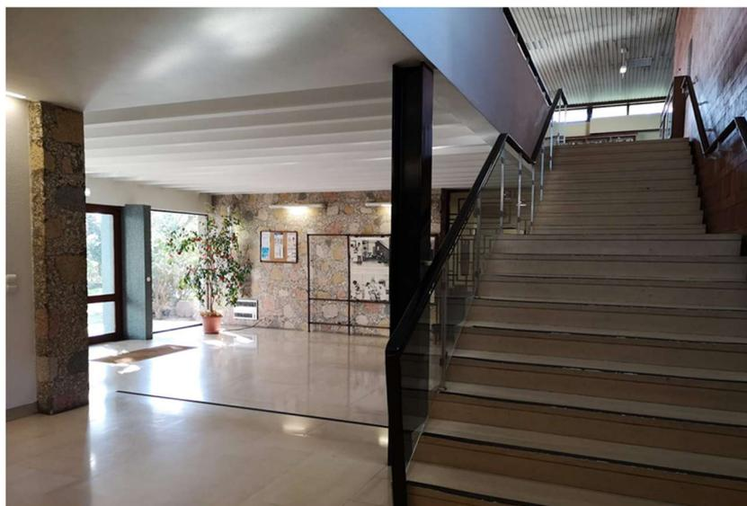
Figura 40 - Via vertical de evacuação sem enclausuramento
