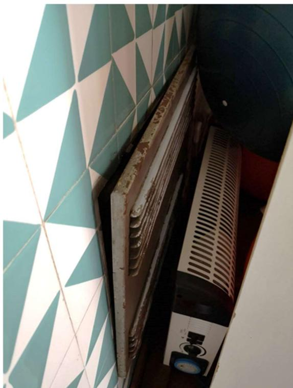
Figura 21 – Aquecimento com deficiente fixação ao suporte no LR
