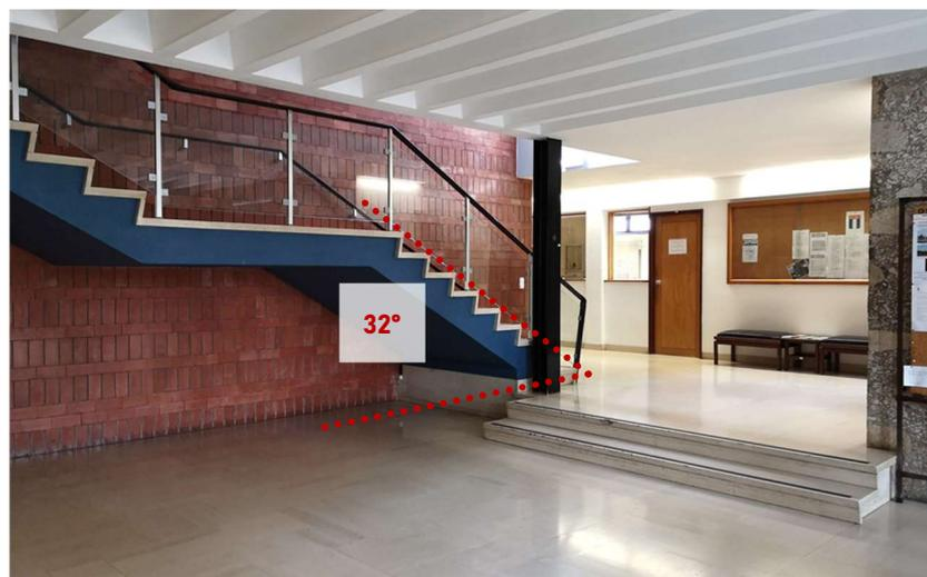
Figura 38 – Via vertical de evacuação com a respetiva inclinação
