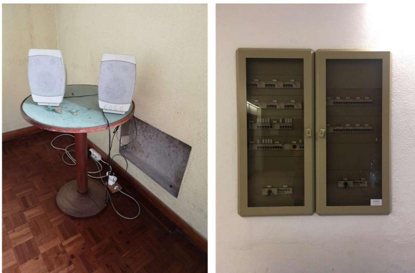
Figura 20 – Instalações elétricas no LR (esquerda) e quadro não-regulamentar na via horizontal de evacuação (direita)
