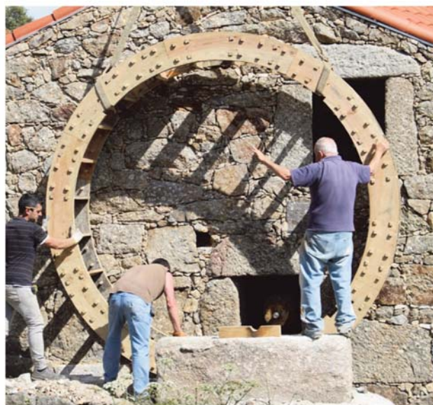
FIG. 5 – Desenho de pormenor para a execução da roda hidráulica vertical (à esquerda) e reconstrução/colocação no local original (à direita).
