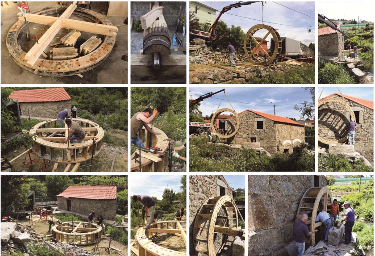
FIG. 6 – Diferentes fases do trabalho de carpintaria para montagem e colocação da roda hidráulica vertical no Moinho de São Marçal.
