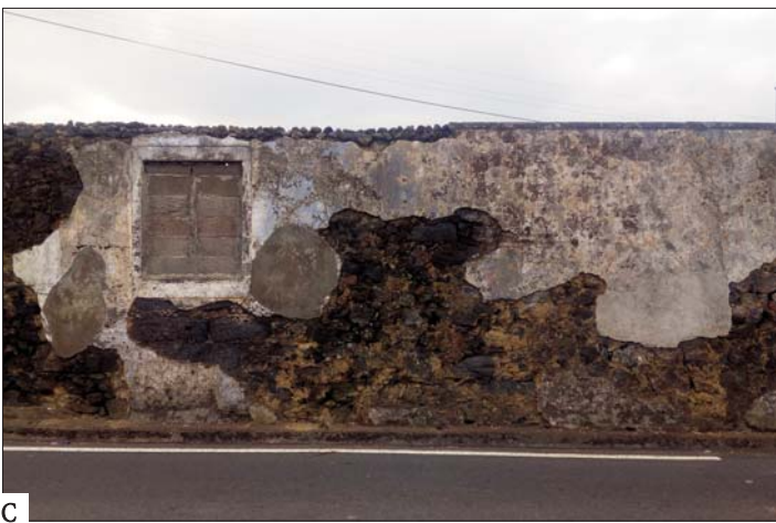
FIG. 5 – Em cima, três casos de estudo de construções tradicionais nos Açores (ANDRADE, 2019).
