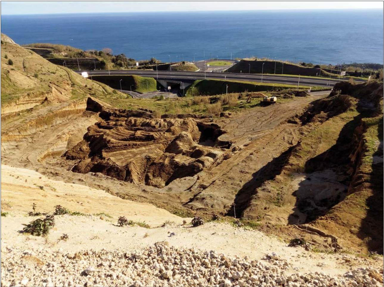
FIG. 1 – Extração de pozolana para a produção de cimento na freguesia de Água de Pau, na ilha de São Miguel (ANDRADE, 2019).
