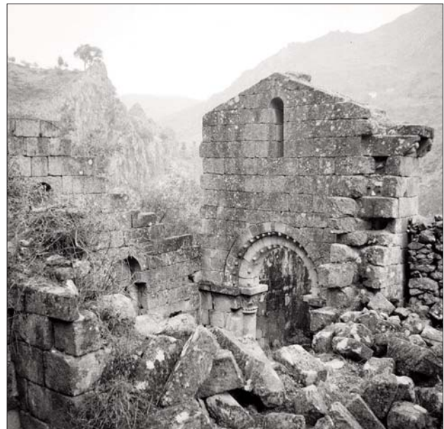
FIG. 1 – Ruína da igreja de São Pedro das Águias (1951) e a igreja durante as obras (1953).
