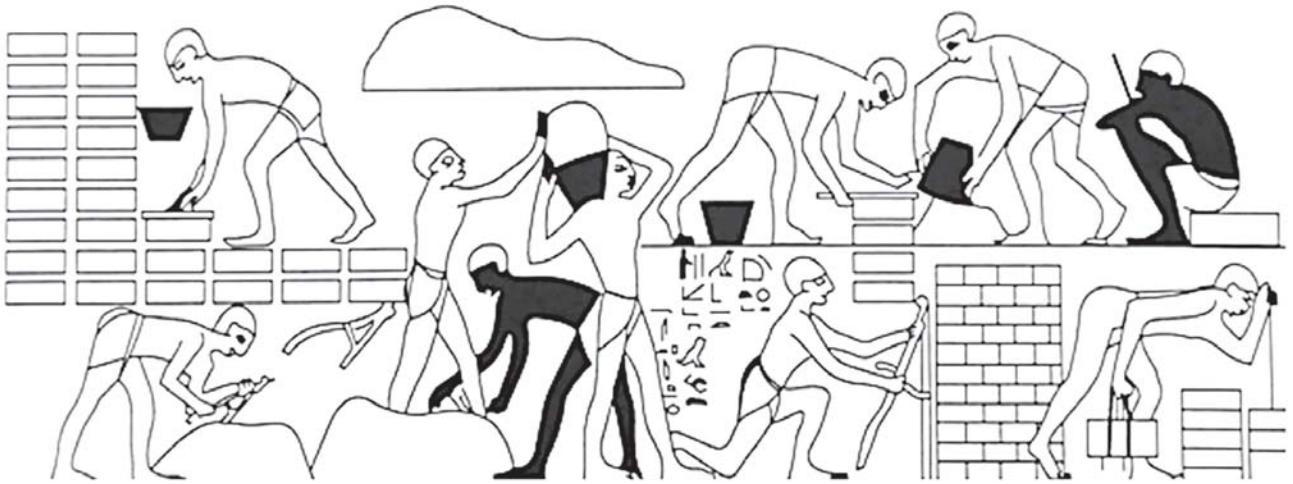
FIG. 1 – Ilustração egípcia, com indicação do método de fabrico e execução de paredes de adobe em 1500 a.C. (SCHROEDER, 2012).
