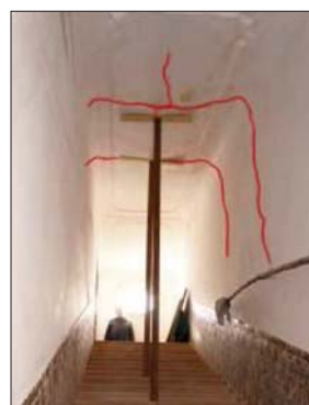
FIGS. 20 E 21 – Em cima, duas vistas da escada de acesso ao terraço, em risco de colapso, com o escoramento existente.
