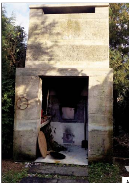
FIG. 3 – Experiências recentes com terra na ilha de São Miguel (Açores). A) Forno; B) Instalação sanitária; C) Sauna (ANDRADE, 2019).
