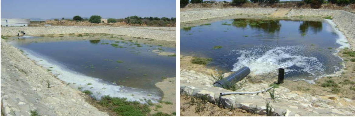
Legenda - Vista geral de uma das três bacias da estação de recarga artificial de Korba localizada no sistema aquífero da Costa Oriental (Cap Bon – Tunísia) com um caudal de alimentação de 1500 m 3 /dia
