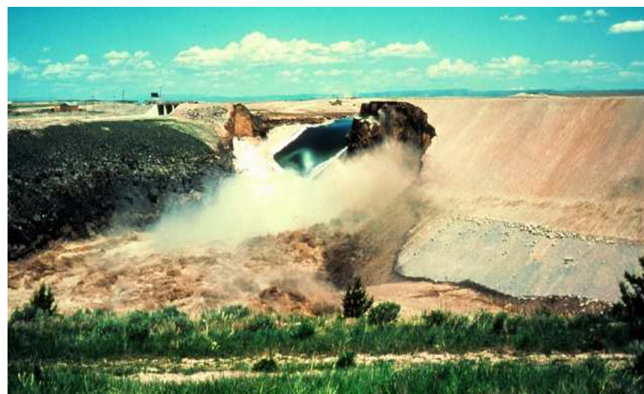
Erosão tubular (barragem de Teton, EUA, 1976)
