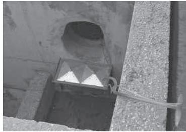
**Figura 10 – Estrutura para a recolha não automática das amostras (auto-estrada A22).**
