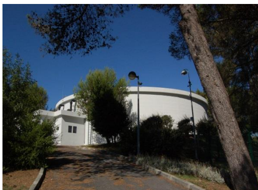
Figura 1 – Local de instalação do udómetro (Reservatório de Santa Catarina)
