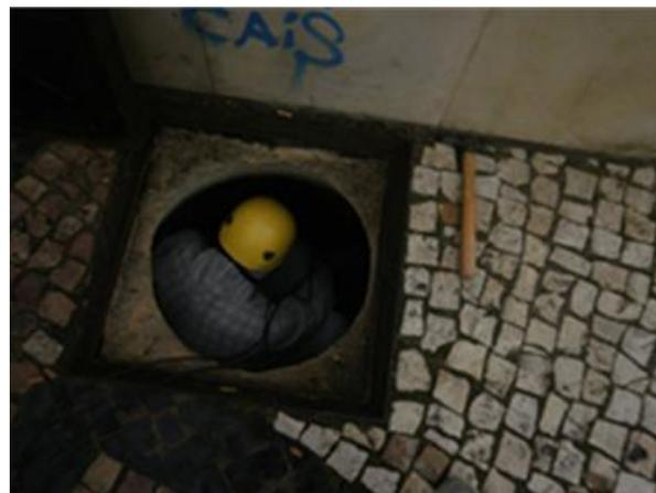
Figura 4 - Instalação de medidor de caudal no ponto SEIXAL 1
