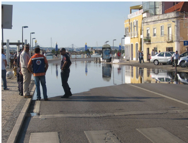
Figura 3 - Aspeto da inundação da via junto à curva da Timbre no dia 29 de setembro de 2015.
