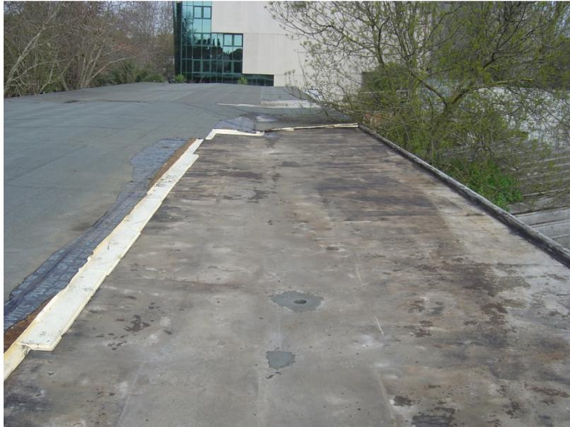
Figura 2-8 O efeito da ação do vento em coberturas em terraço: levantamento do sistema de impermeabilização e isolamento térmico
