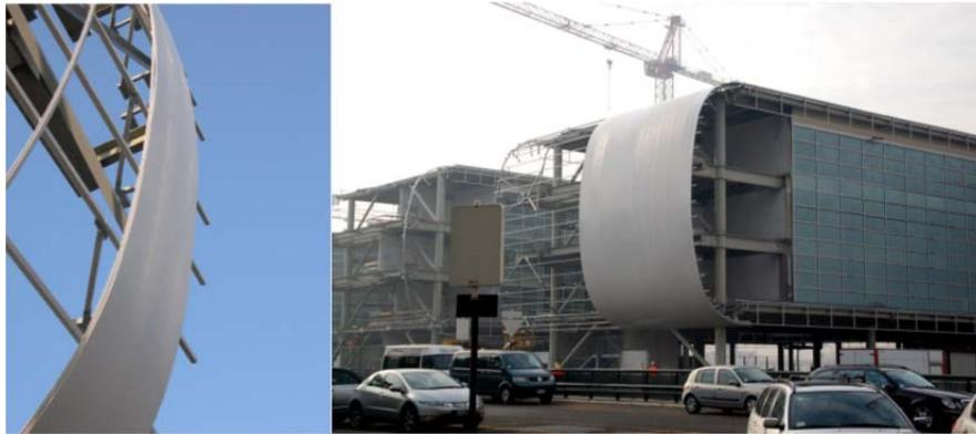
Figura 2-2 Exemplo de uma aplicação de painéis de fachada – Hotel Sheraton no aeroporto de Malpensa (retirado do Anexo I do programa de trabalhos do projeto BioBuild)
