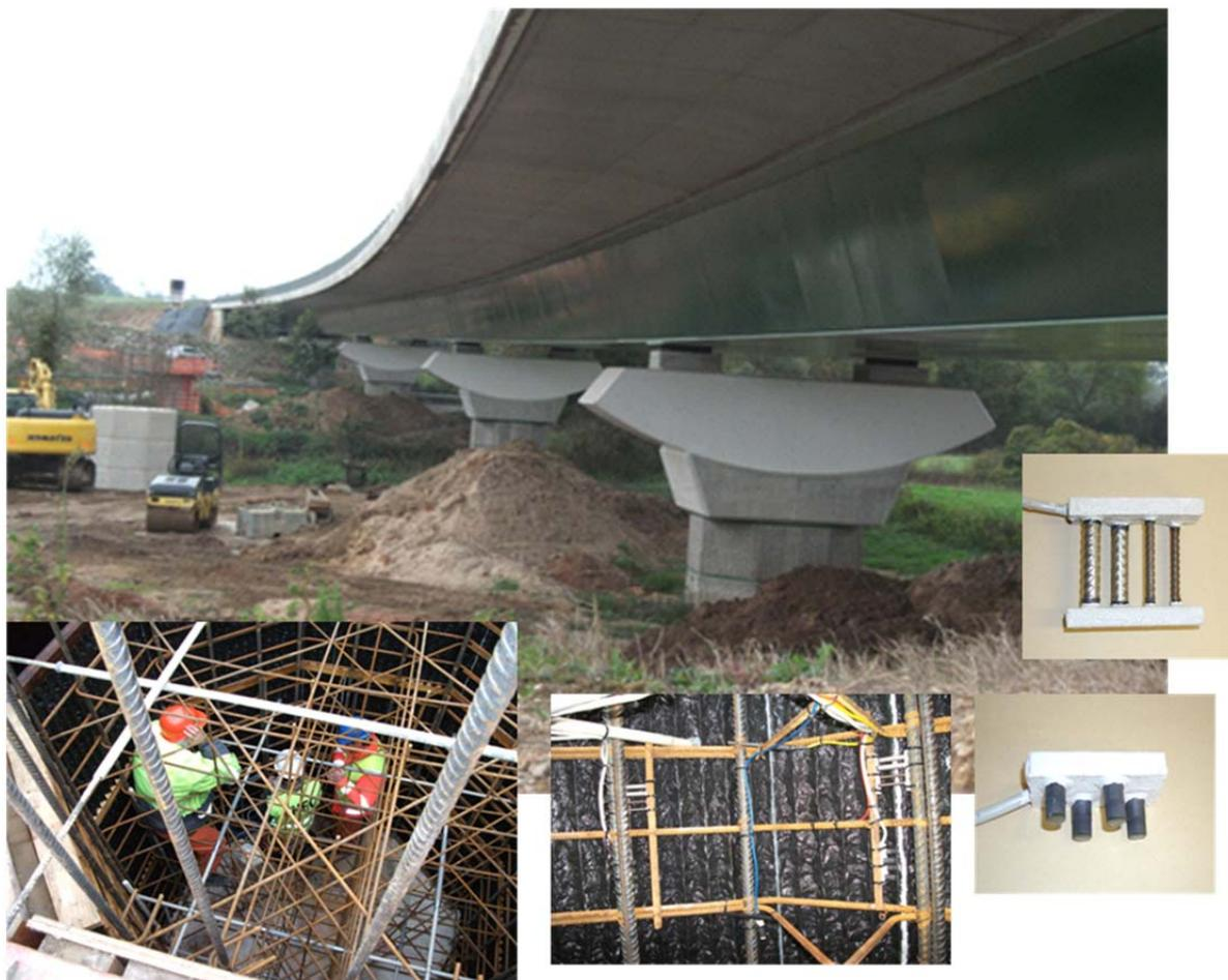
Desenvolvimento e instalação de um sistema de monitorização da corrosão para um viaduto em França
