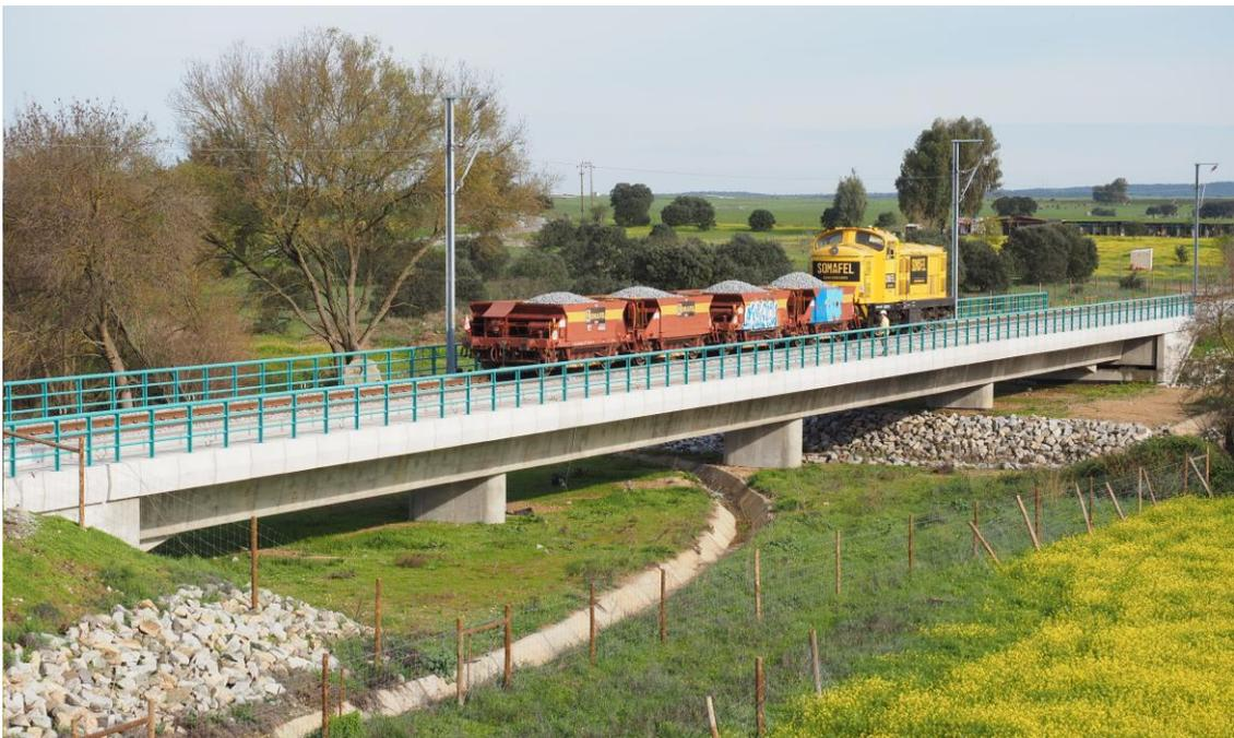
Figura 42 – Ensaio da ponte do Degebe, na Linha de Évora, no Corredor Internacional Sul
