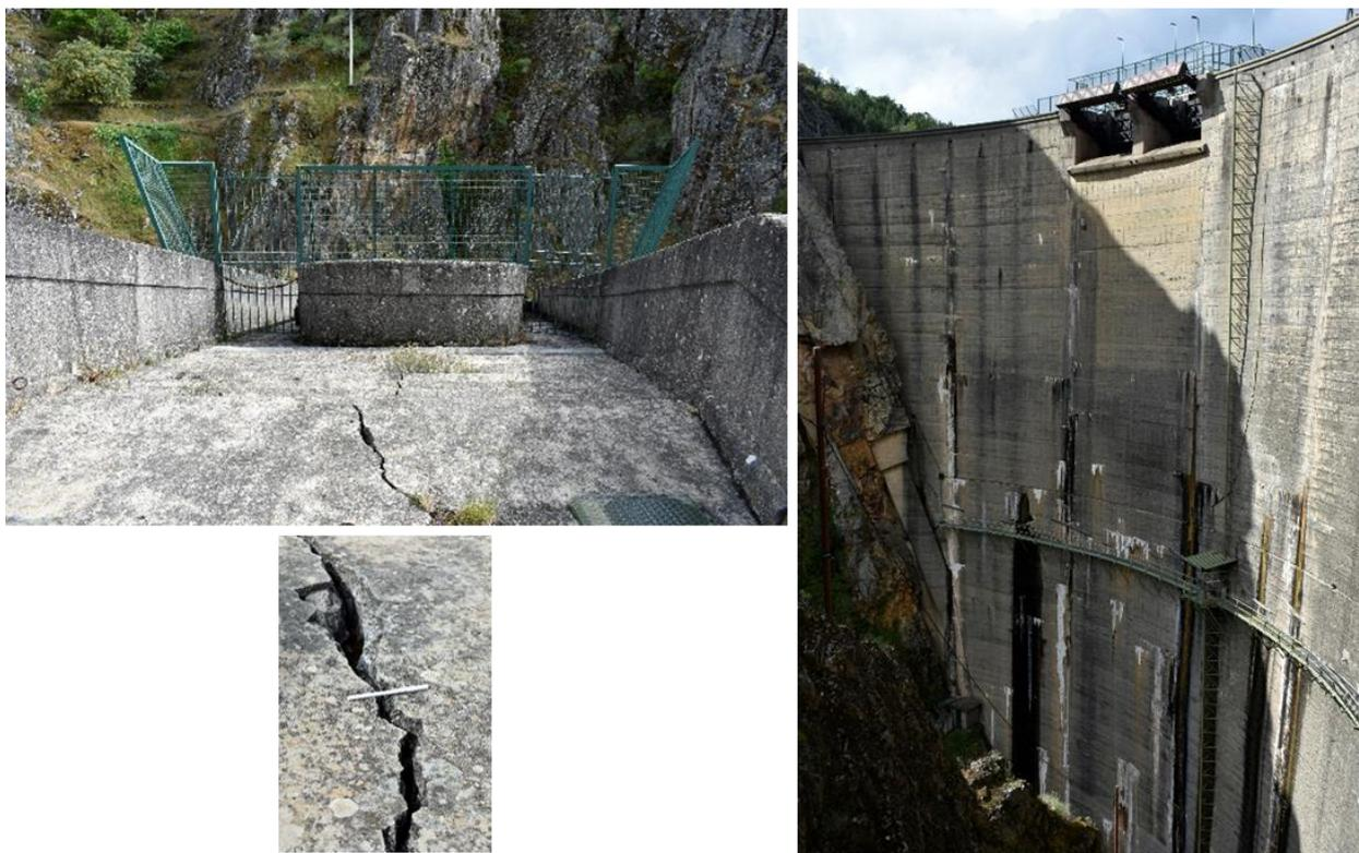
Figura 52 – Barragem de Santa Luzia afetadas por reações expansivas de origem interna
