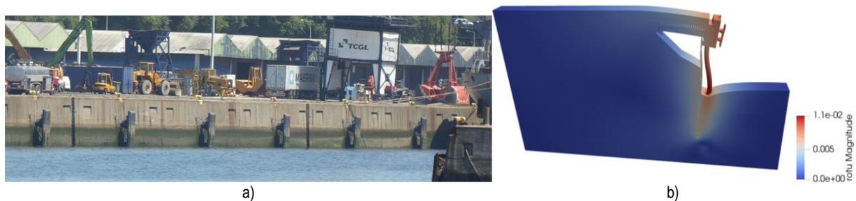
Figura 15 – Terminal da Doca 4: a) vista geral; b) modelo de elementos finitos de um módulo da doca
