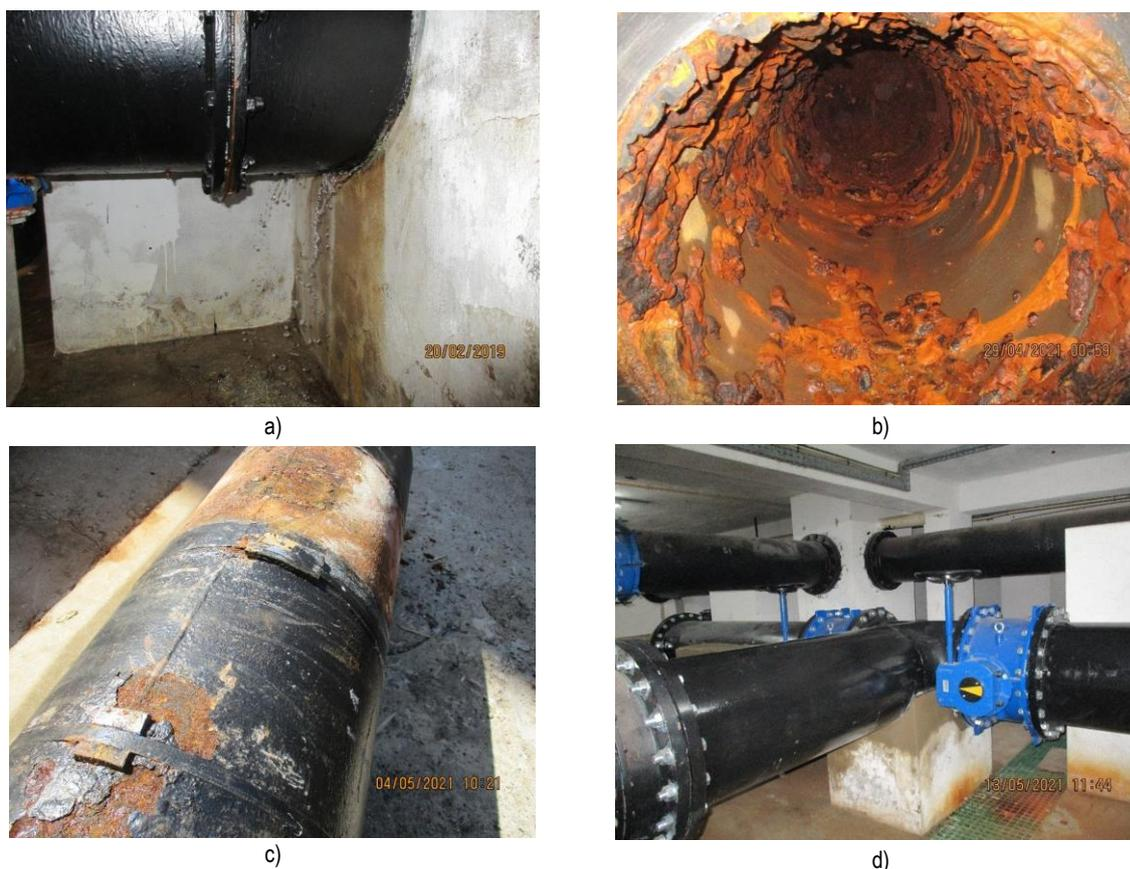
Figura 48 – Aspetos da intervenção de reabilitação em condutas: a) perda de água na ligação entre a conduta e a parede (antes de intervenção); b) interior da conduta (antes de intervenção); c) exterior da conduta (antes de intervenção); d) condutas novas (após intervenção)
