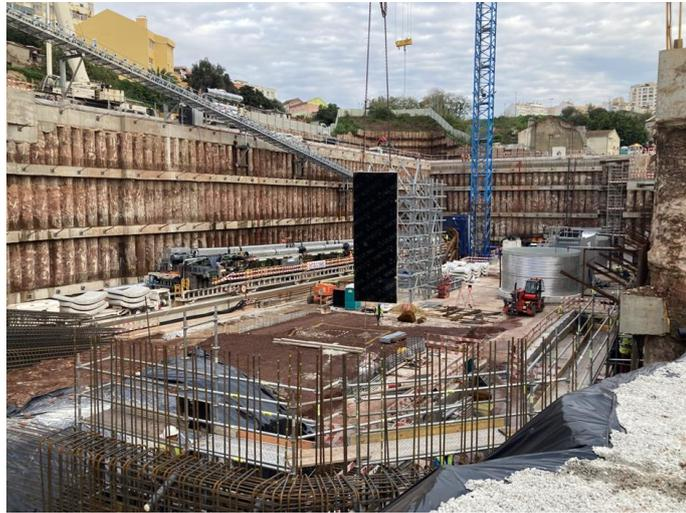
Figura 46 – Escavação da bacia antipoluição do Plano Geral de Drenagem de Lisboa
