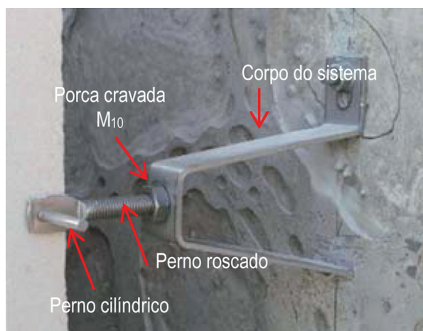
Figura 1 – Elementos do sistema de fixação PATA MECÂNICA – PR
