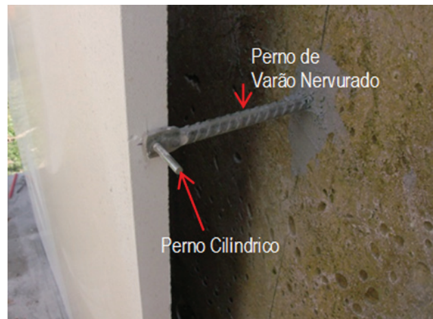
Figura 1 – Elementos do sistema de fixação PERNO DE VARÃO NERVURADO – PV
