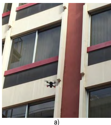
Figura 36 – Inspeção com drone de elementos de betão pré-fabricados em fachada de edifício: a) vista geral; b) pormenor
