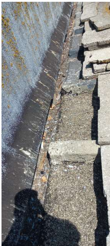
Figura 3.1 - Maciços de apoio às lajetas
