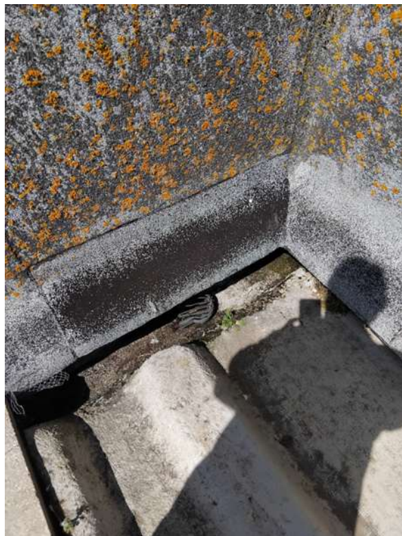
Figura 3.2 - Abas de remate a demolir
